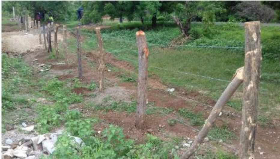
Construcción de cerca perimetral
