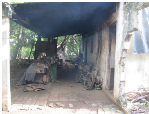
Imagen 4. Ruinas del antiguo campamento.
